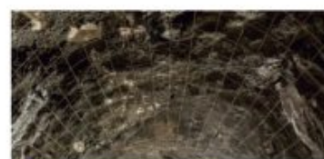
3. Au fur et à mesure du creusement, un treillis métallique est fixé sur les parois.
