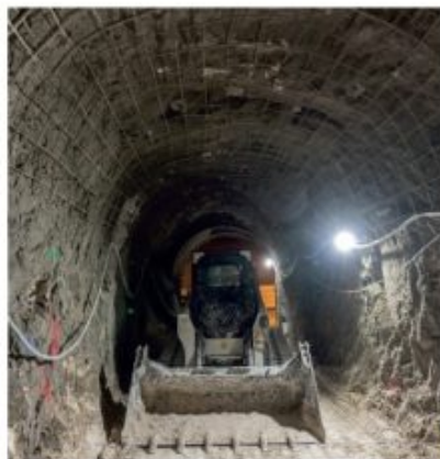
2. Le creusement s'effectue à l'aide d'un engin équipé d'un brise roche hydraulique et l'évacuation des déblais avec une minipelle.
