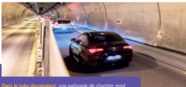
Dans le tube descendant, une palissade de chantier rend le chantier indépendant et invisible de la voie de circulation.
